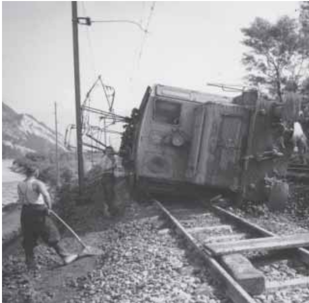
Verletzliche Zivilisation, verletzte Infrastruktur: Im Juli 1963 bringt die Maschänser-Rüfe bei Trimmis eine SBB-Lokomotive zum Entgleisen. Bild: Tiefbauamt Graubünden
