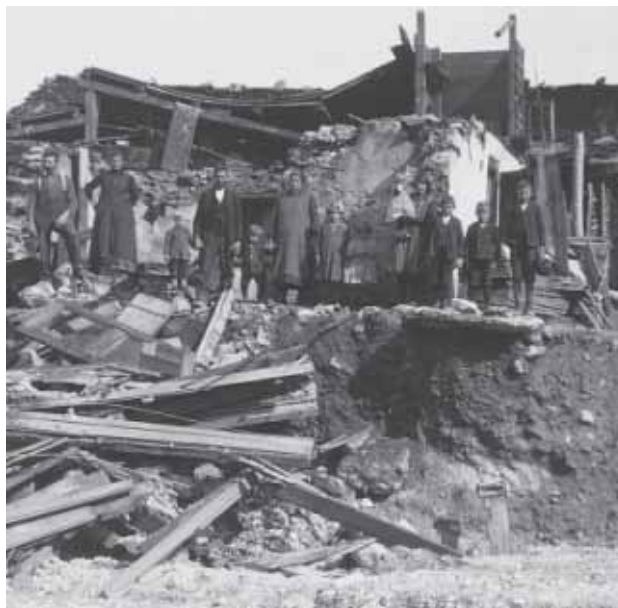
September 1927: Nach den verheerenden Unwettern in Zignau (ehemals Ringgenberg, Gemeinde Trun) stehen die Familien Decurtins und Tomaschett vor dem Ruin. Sie sind auf fremde Hilfe angewiesen. Bild: Tiefbauamt Graubünden.
